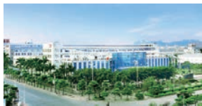
Завод в г.Жангжоу
